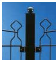
Les poteaux sont de section carrée, en tube soudé, avec un profil de 60 x 60 x 1,50 mm. Pour l'esthétisme, les poteaux sont pourvus d'un capuchon avec une boule en métal décorative.
